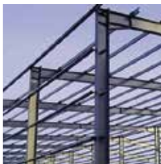
ESTRUTURAS METÁLICAS PREDIAIS
